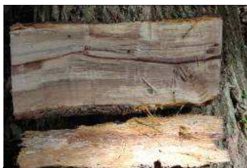
材の外側の菌回りと芯材の水抜け状況
