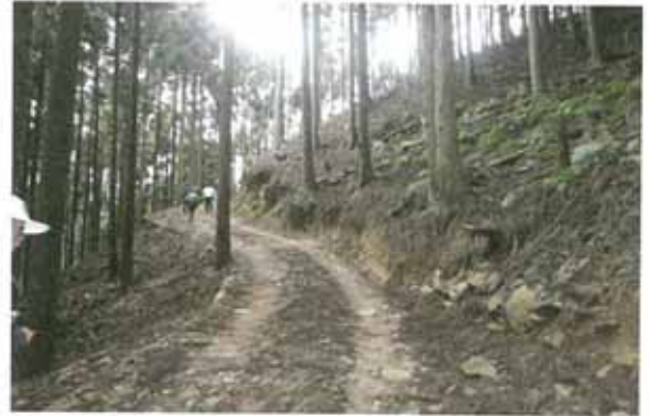
小林 温さん作設の壊れにくい作業道
