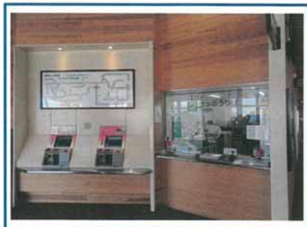
使われているスギの壁材は基本的に「無節」
