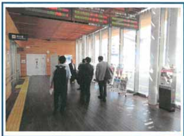
床材は外材で、スギ材より濃い色で塗
