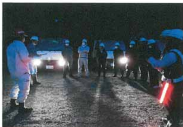
作業前の安全確認及び作業打合せ
